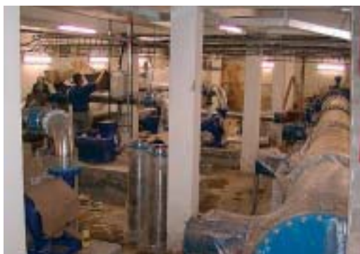
▲ Rekonstrukce čerpací stanice na Zelené Lišce, 3/2001 - 12/2001
