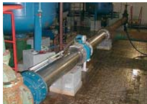
▶ Vybudování nové měřicí trati pro měřidlo průtoku DN 300 - výtlač Zličín, vodojem Kopanina, vč. přenosu dat na centrální dispečink 12/2001
