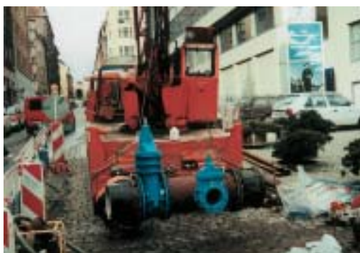
▲ Obnova vodovod. řádu v ul. Heřmanova, Praha 7, 8/2000 - 3/2001
