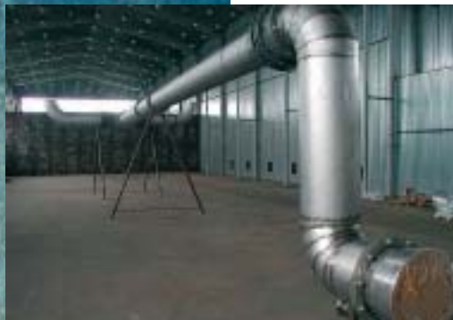
◀ Vybudování nové měřicí trati pro měřidlo DN 500 vč. přenosu dat na centrální dispečink - vodojem Bruska, 10/2001
