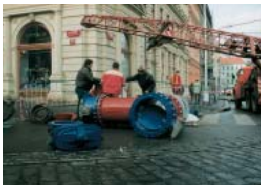
▲ Rekonstrukce vodovodu Karlín, I. etapa, Praha 8, 7/2000 - 5/2001
