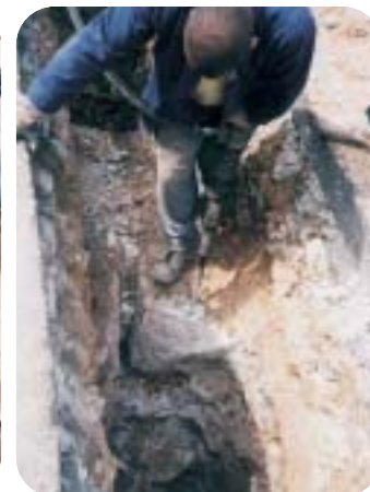
Obnova vodovodních řadů
