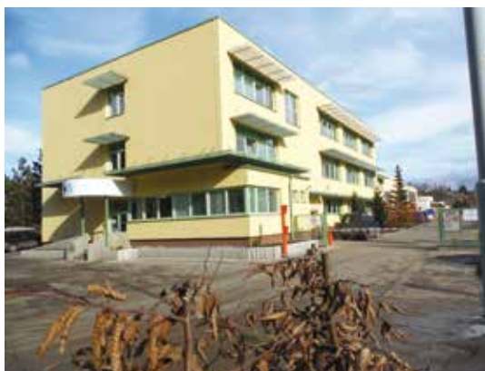
▲ Zateplení provozní budovy na ČOV II Mladá Boleslav
