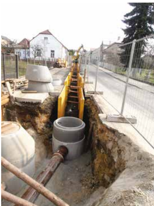
▲ Dobrovice, dostavba kanalizace
