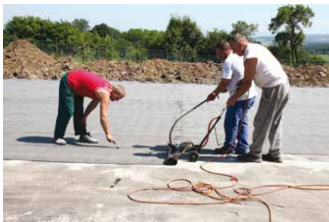
▲ Vodojem Bradlec, obnova hydroizolací
