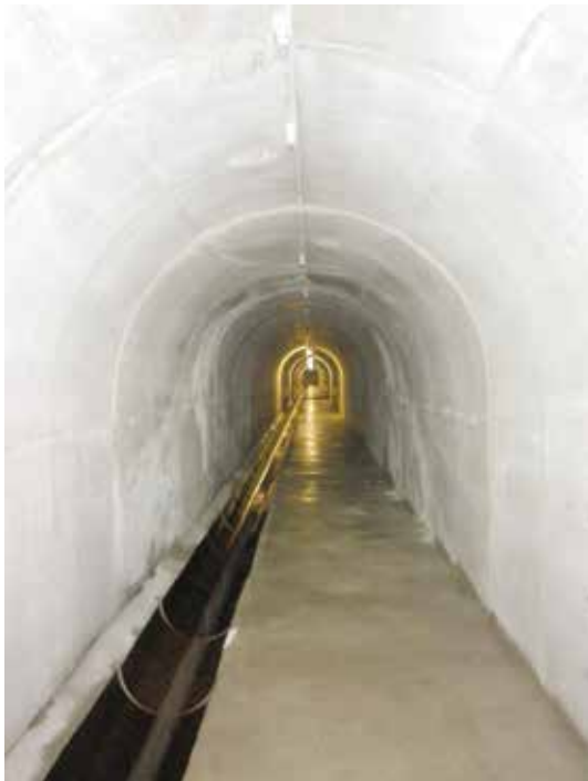
▲ Mnich. Hradiště, betonáž žlabu v kanal. štole.
