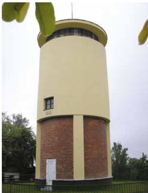
▲ Bezdědice, vodojem po opravě
