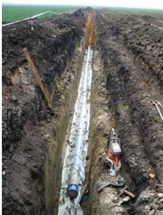
▲ Dobrovice, budování přivaděče pitné vody
