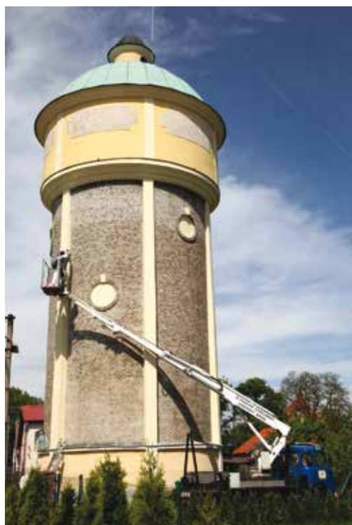
▲ Bezno, oprava vodojemu
