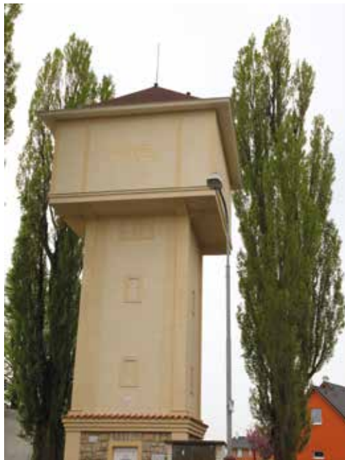
▲ Čejetice, vodojem po opravě
