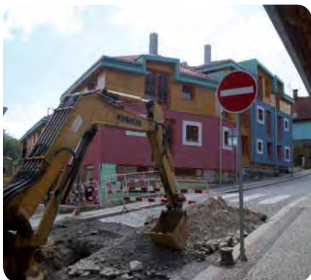
▲ Oprava vodovodního řadu v Příčné ulici v Mnichově Hradišti
