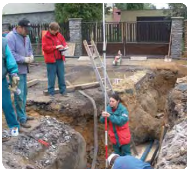
▲ Oprava vodovodního řadu ve Velenského ulici v Bělé pod Bezdězem
