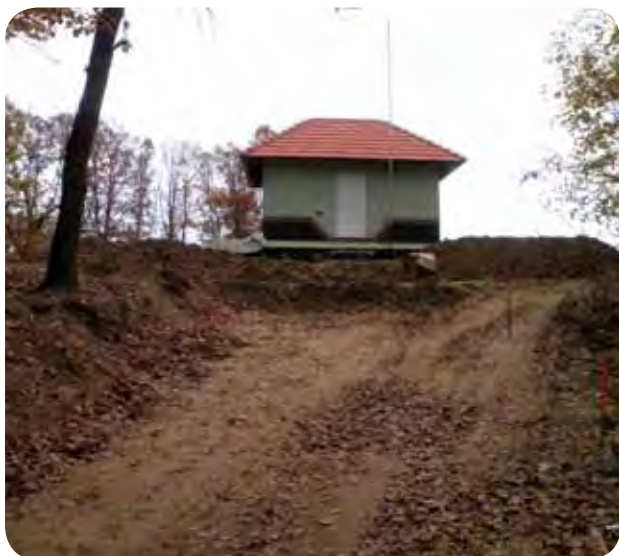
▲ Výstavba nového vodojemu pro obec Dneboh
