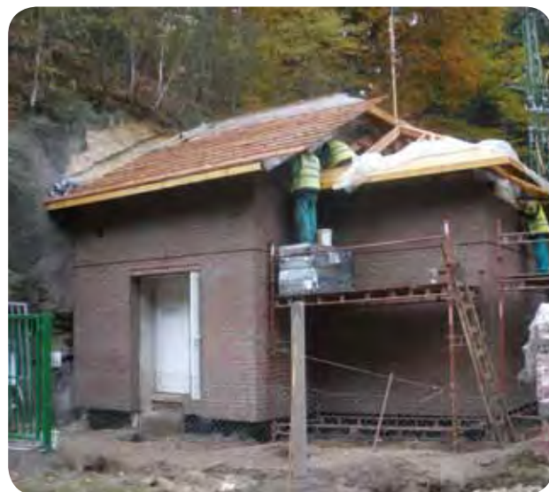
▲ Rekonstrukce objektu čerpací stanice v Bezdědicích
