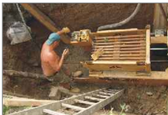
▲ Výměna vodovodního potrubí bezvýchopovou metodou v obci Líny
