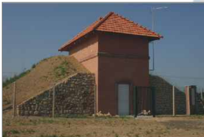
◀ Vodojem v obci Písková Lhota po provedené rekonstrukci
