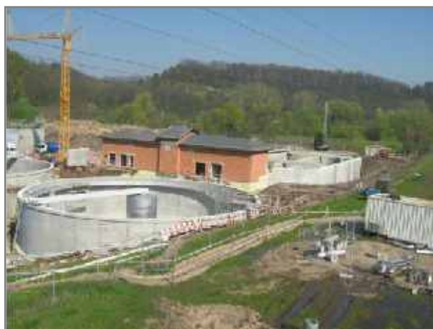
► ČOV I Mladá Boleslav - Neuberk stavba intenzifikace
