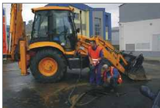
Porucha na vodovodním řadu DN 300 u prodejny PLUS v Mladé Boleslavi
