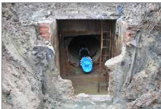
▲ Čelo podchodu DN 1500 mm pod rychlostní komunikací R 10
