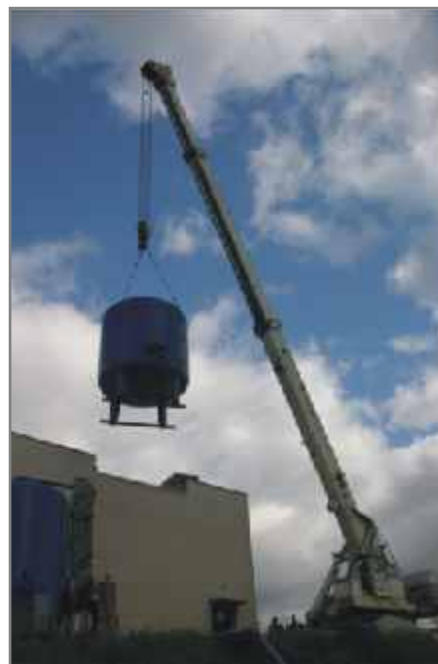
▲ Obnova technologie ÚV v Dobrovici
