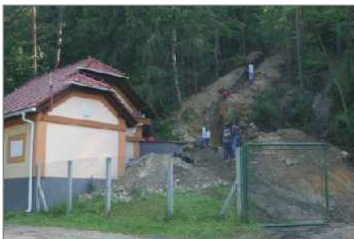
▲ Výstavba výtlačného řadu v Bělé pod Bezdězem
