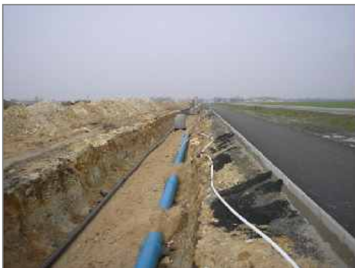
▲ Výstavba vodovodního a kanalizačního přivaděče do obce Bezděčín
