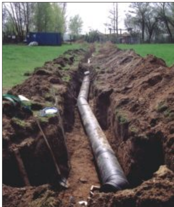
▲ Celková obnova hlavních výtlačných řadů v Benátkách nad Jizerou
