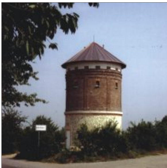
Rekonstrukce věžového vodojemu v Kovánci
