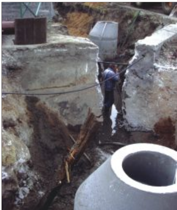
▲ Výstavba kanalizace v obci Bezděčín
