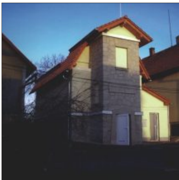
Rekonstrukce nadzemního vodojemu v obci Skalsko
