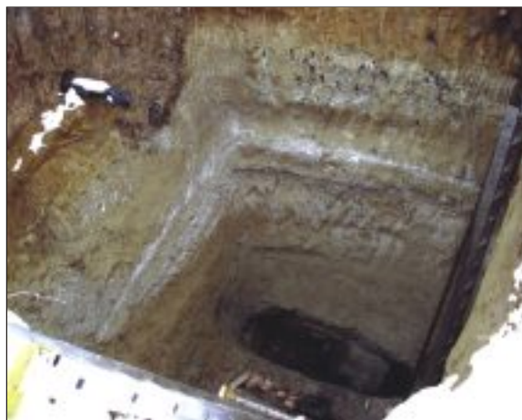
▲ Oprava kanalizace v Mnichově Hradišti, ul. Ivana Olbrachta
