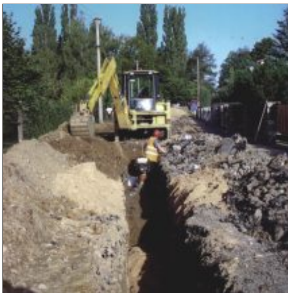
Rekonstrukce vodovodního řadu v Čachovicích
