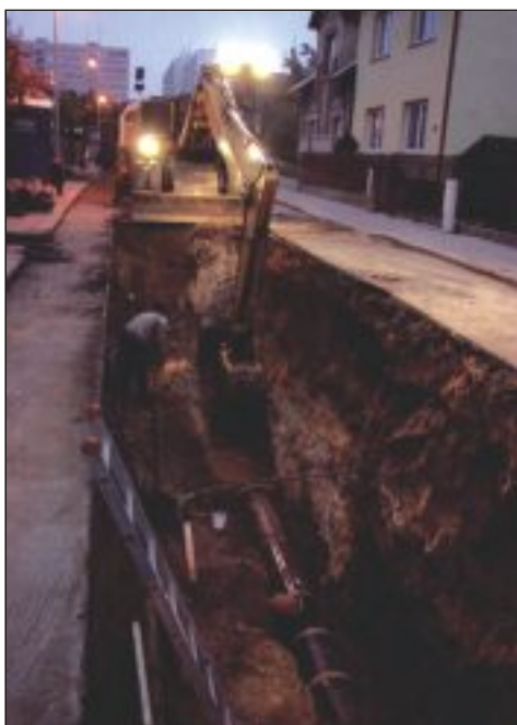
Výměna kanalizační stoky v Mladé Boleslavi, ul. Galetova
