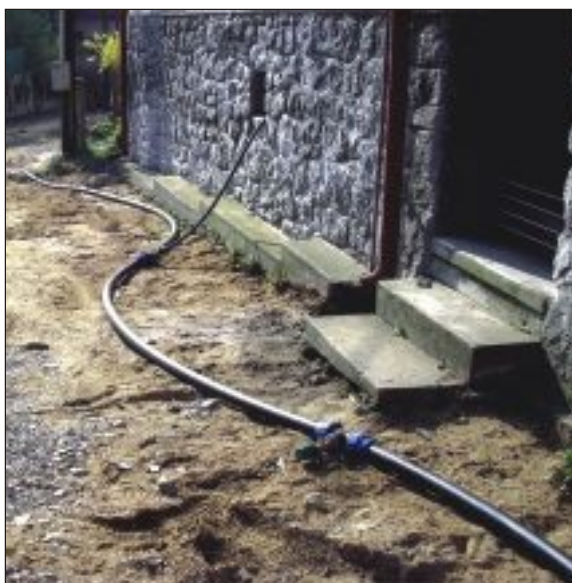
Rekonstrukce vodovodního řadu v ul. Hluboká, Mnichovo Hradiště - dočasný povrchový vodovod
