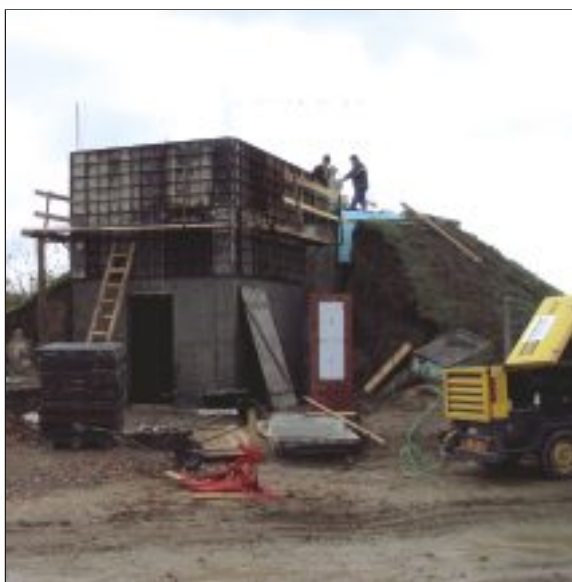
Rekonstrukce zemního vodojemu Písková Lhota
