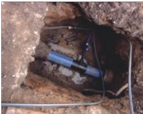
▲ Sanace ocelového vodovodního řadu v Mnichově Hradišti, ul. Turnovská
