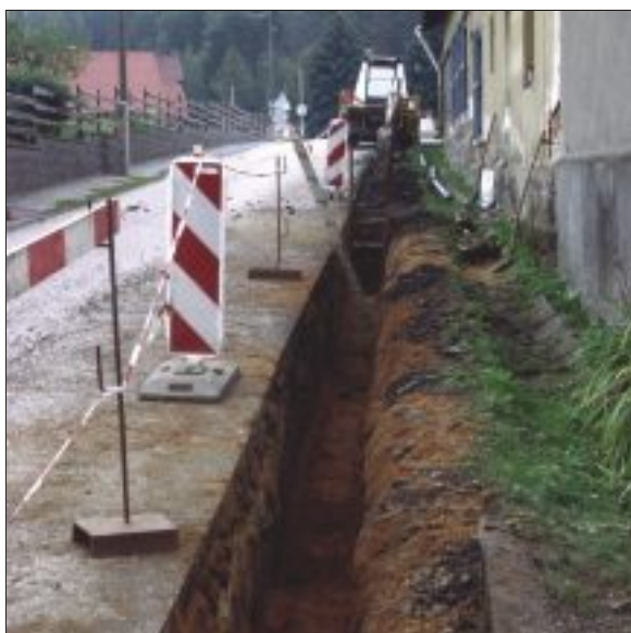
Výměna vodovodních řadů v Dnebohu
