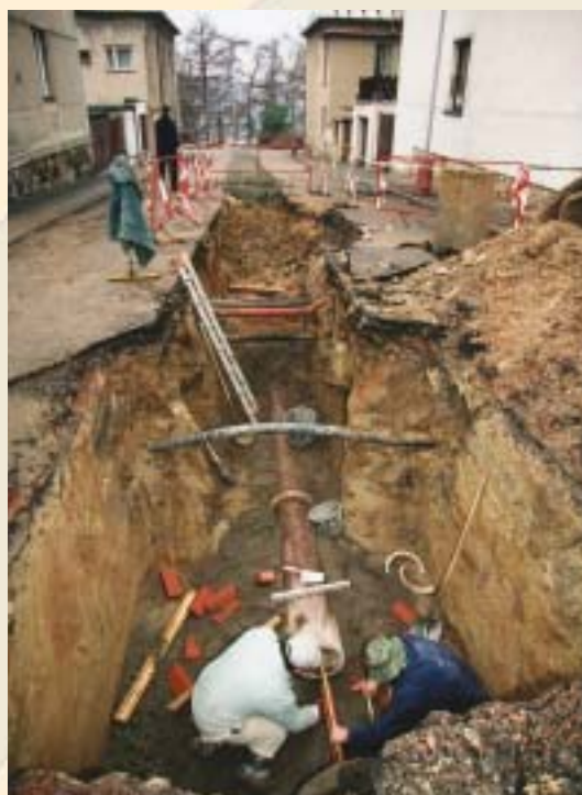
Mladá Boleslav - místní část „Kolonie“ - oprava kanalizačních stok
