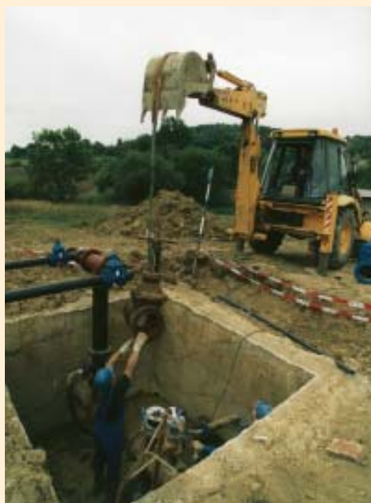
Skupinový vodovod Mnichovo Hradiště Přípravné práce pro cementaci hlavního výtlačného řadu
