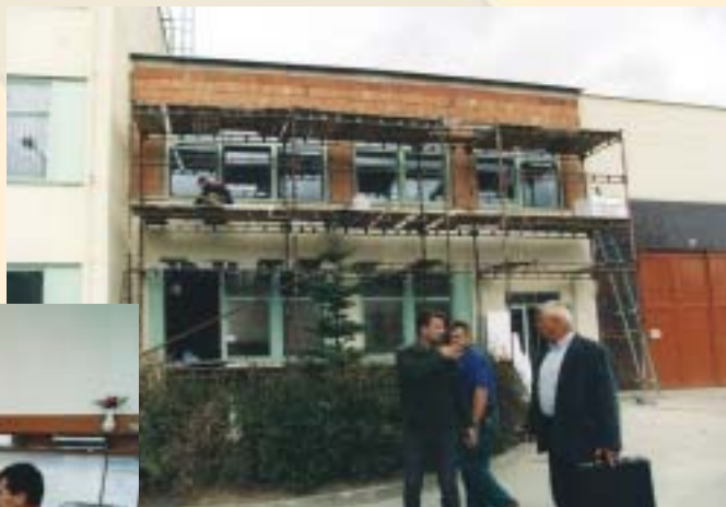
Nástavba provozní budovy na ČOV II Mladá Boleslav - Podlázky
