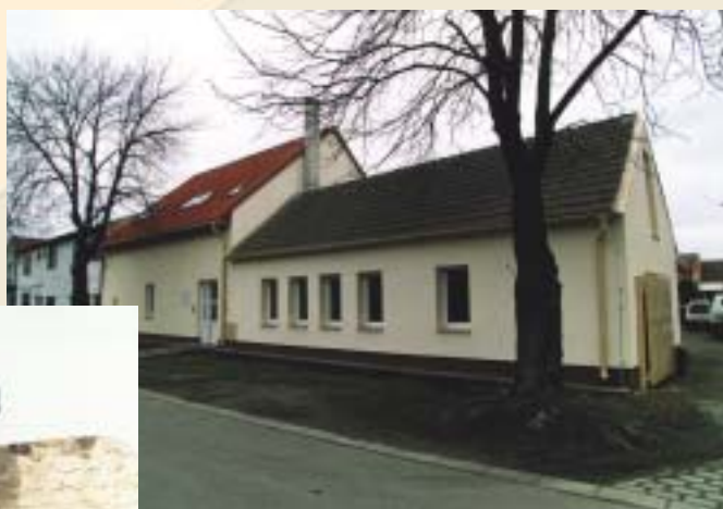
Provozní středisko Čelákovice
